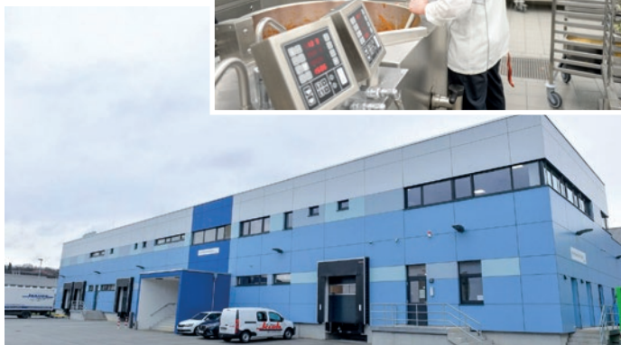
Die neue Mülheimer Großküche der Contilia-Gruppe versorgt die umliegenden Krankenhäuser, u. a. das St. Marien-Hospital
