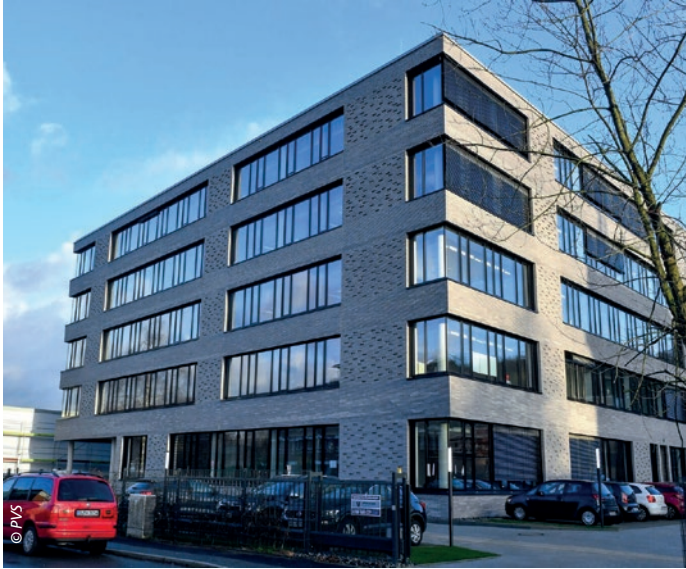
Die PVS holding GmbH bezog 2018 ihr neues Verwaltungsgebäude in Saarn
